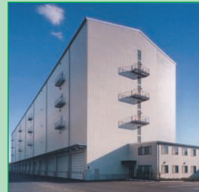
●京義倉庫新築工事（千葉県船橋市）
