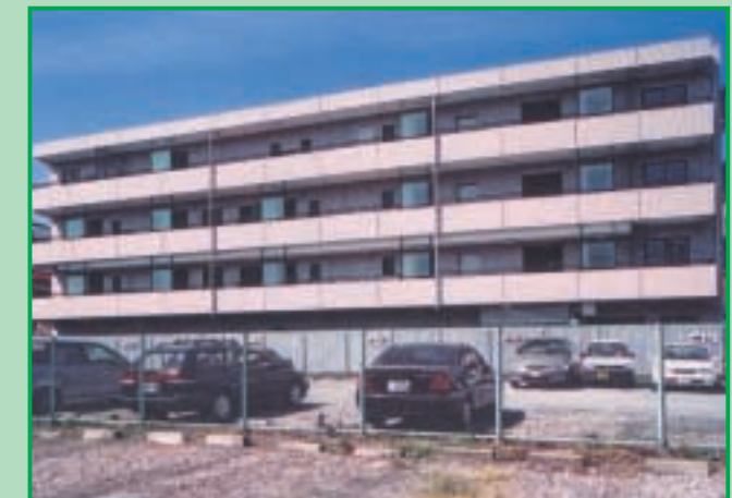
●池上3丁目マンション新築工事（東京都大田区池上）
